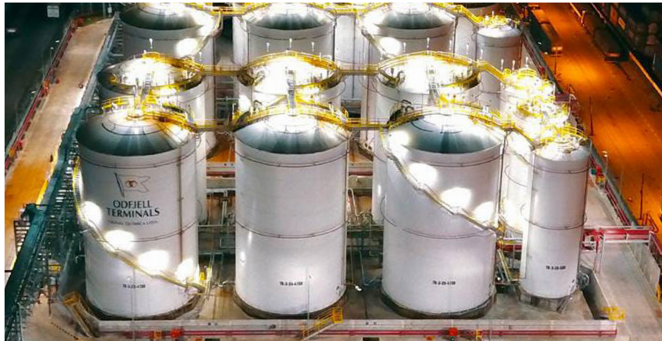
La iluminación LED está presente en toda nuestra terminal: calles internas, tanques, pasarelas, plataformas de carga y edificios administrativos.
